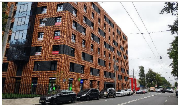
Фотография 3.6. Жилой дом по адресу г. Санкт-Петербург, пр. Петровский, д. 11, корп. 2
