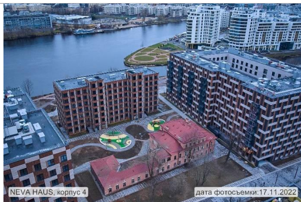
Фотография 3.3. Жилой дом по адресу г. Санкт-Петербург, пр. Петровский, д. 11, корп. 3
