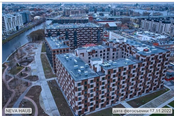
Фотография 3.1. Жилой дом по адресу г. Санкт-Петербург, пр. Петровский, д. 11, корп. 3
