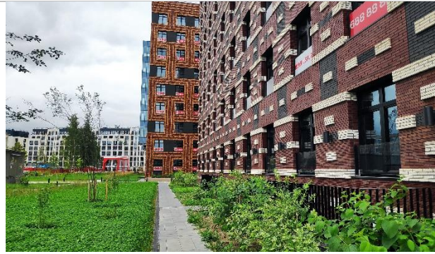
Фотография 3.8. Придомовая территория
